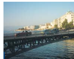
Η μεταλλική γέφυρα που συνδέει τη Στερεά Ελλάδα με την Εύβοια στη Χαλκίδα
