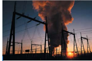
Θερμοηλεκτρικό εργοστάσιο παραγωγής ενέργειας
